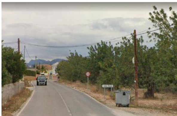
Imagen 17.3: Líneas aéreas de telefonía junto a UE Pouet.
