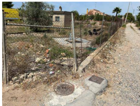
Imagen 17.6: Arqueta de riego en interior parcela. Coordenadas: X = 711997.3350 Y = 4387558.3686
