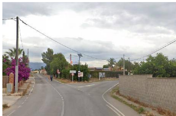
Imagen 17.4: Líneas aéreas de telefonía en UE Aljubs.
