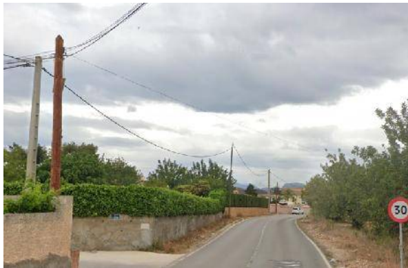
Imagen 17.1: Línea aérea de baja tensión junto a UE Pouet.
