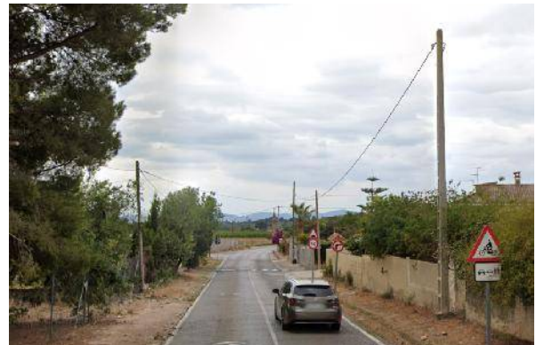
Imagen 17.2: Líneas aéreas de telefonía en UE Aljubs.
